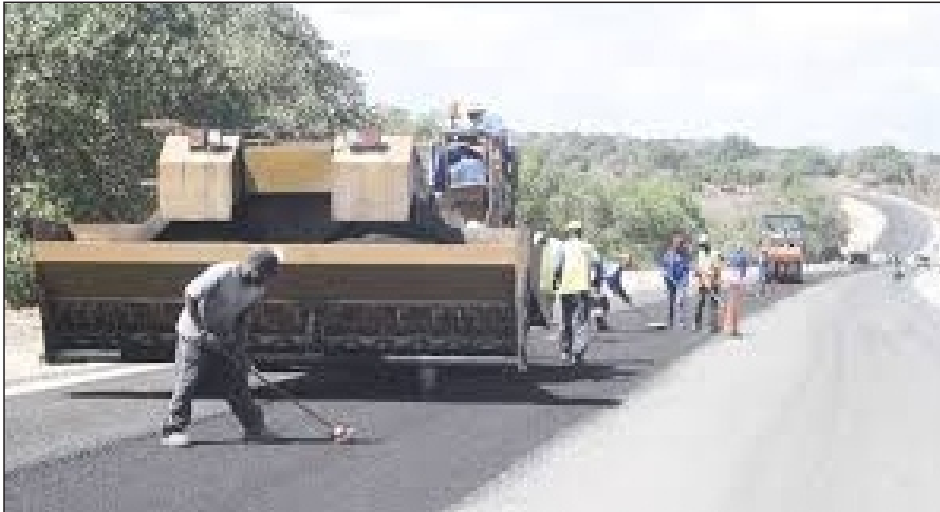
Para dar lugar à construção duma estrada, SASOL vandaliza culturas agrícolas, em Vilanculos.
