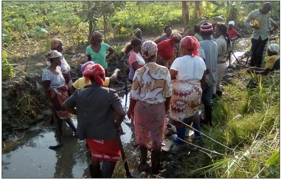
Camponeses e camponesas de Muelé 1, na Cidade de Inhambane, limpando a vala de drenagem.
