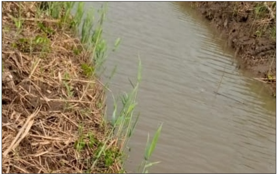
Vista parcial da Vala de Drenagem, em Marracuene, depois dos trabalhos de limpeza.
