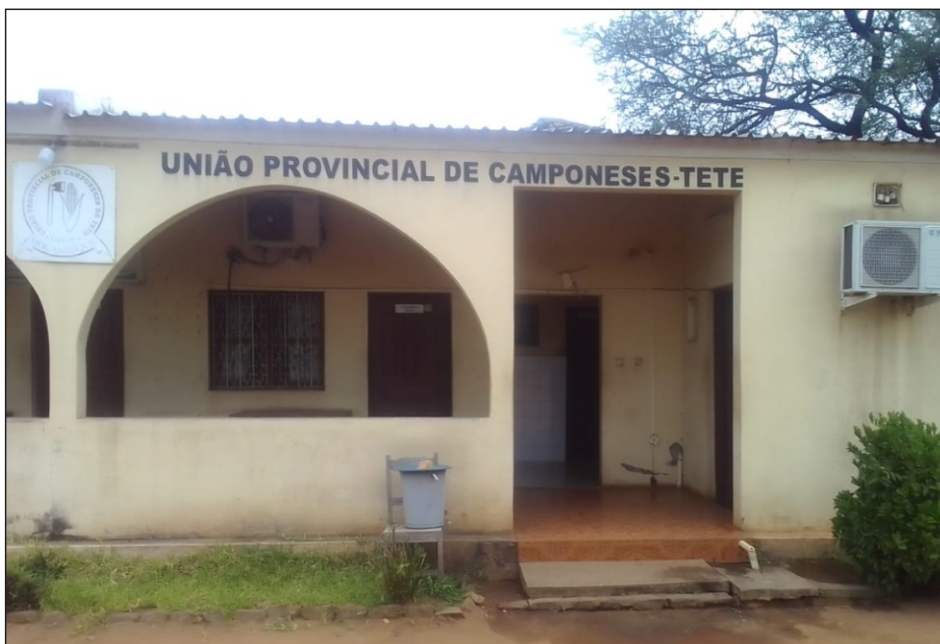
Fachada dos Escritórios-Sede da UPCT, que celebrou, recentemente, 20 anos de existência.
